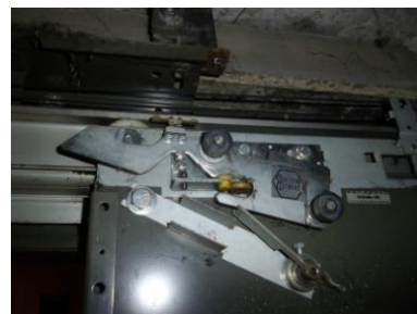
Serrure de porte palière du niveau principal
